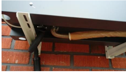
Kuva 6. pakoputki ja paloilmanotto
